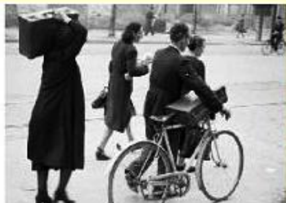
Cittadini che lasciano Milano dopo il bombardamento del 13 agosto 1943 che causò devastazioni ovunque, sia in centro che in periferia. Furono colpiti anche il duomo, la galleria, chiese, musei. (Foto archivio Comune Cinisello Balsamo)
